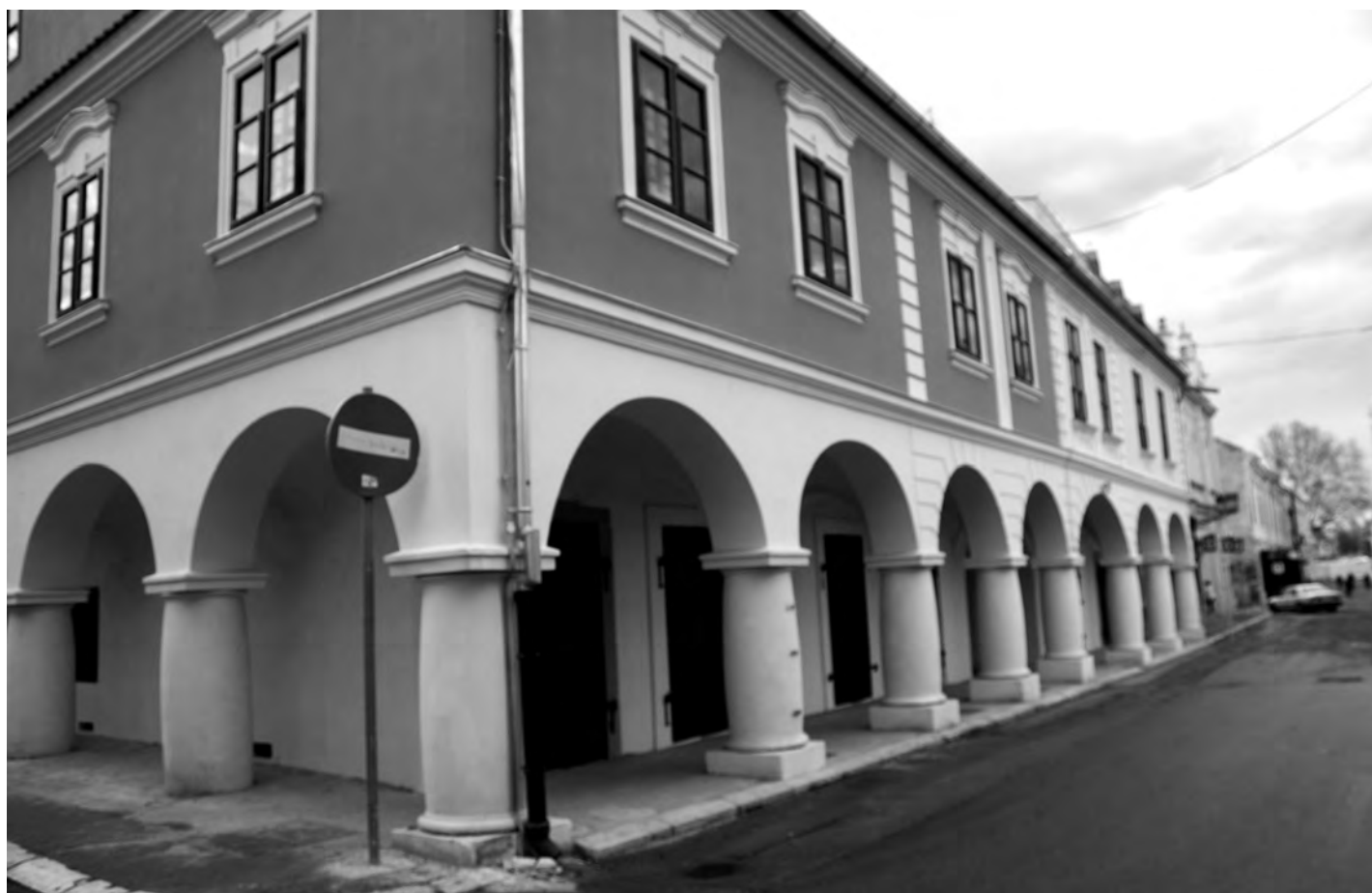
Magaza Mihailovića, barokna građevina iz 1760. godine
