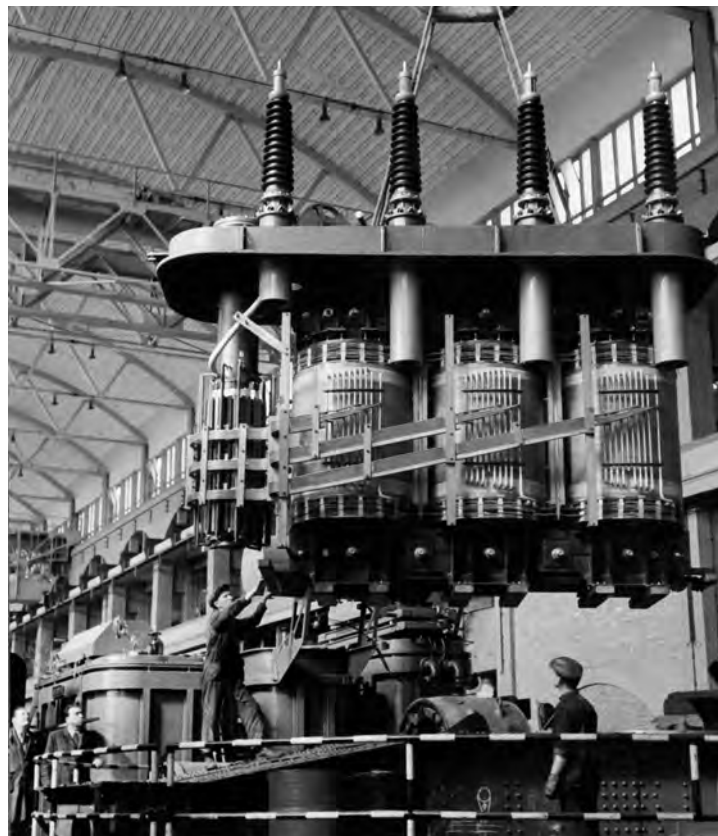
Detalj iz proizvodnje transformatora u tvornici Rade Končar, presnimka fotografije, Zagreb, 1954. / Muzej grada Zagreba
