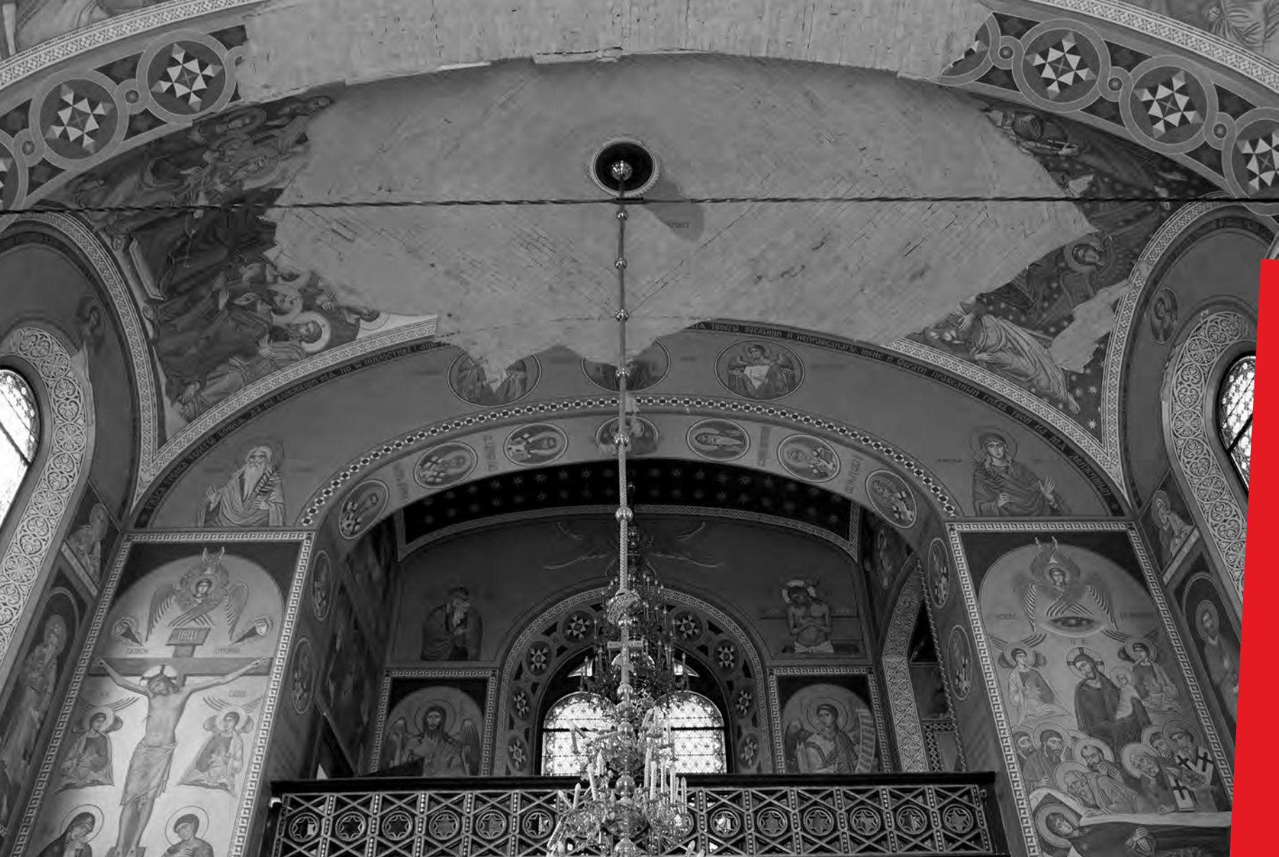
Оштећења фреска и свода првога западног травеја Преображењског храма; фот. аутора чланка, 28. 3. 2020.
