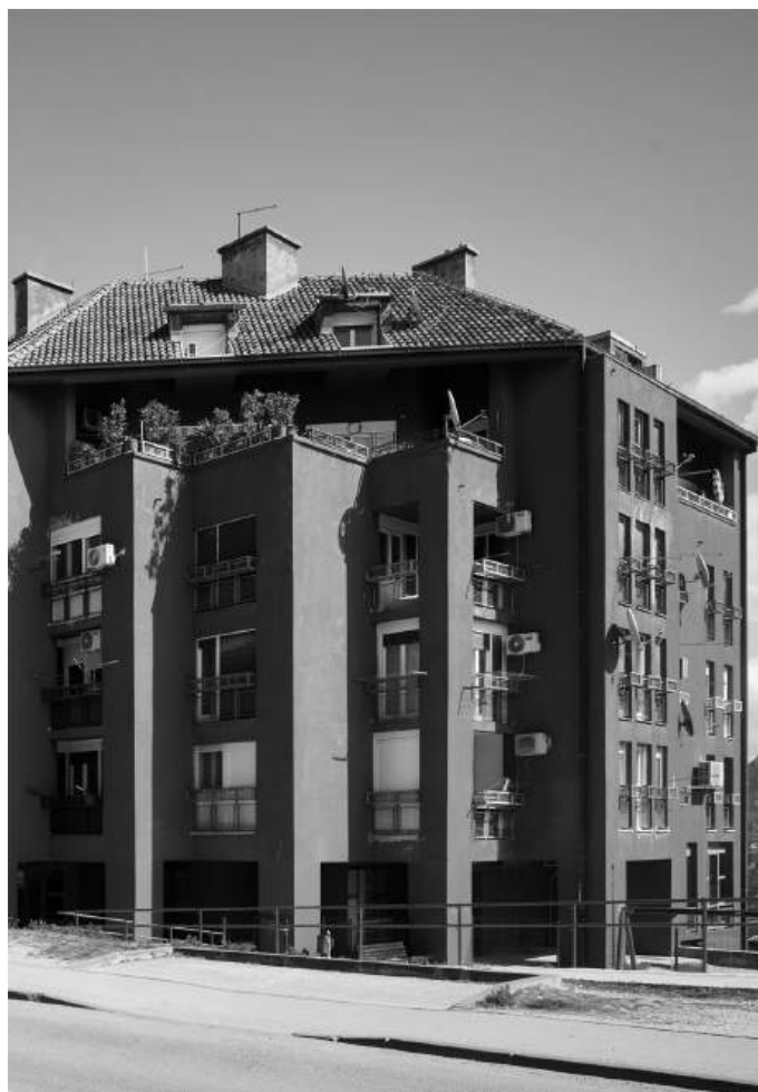
Stambeno-poslovna zgrada u Kninu, (projektirana 1986, realizirana 1990.) Fotografija: Sandro Lendler, 2026.
